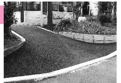
改修後の歩道
