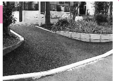
改修後の歩道
